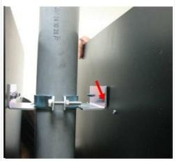
Скрепите кронштейны при помощи винта в верхней части трубы
