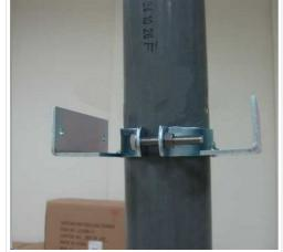
Соедините два кронштейна в верхней части трубы при помощи винтов, шайб и гаек М8
