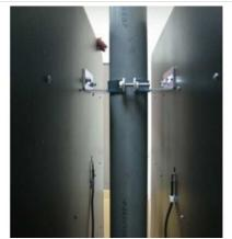
Знаки должны быть закреплены кронштейнами в верхней части трубы
