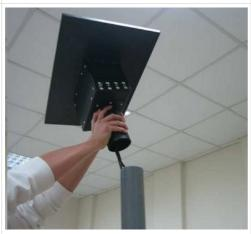
Поместите электрические провода в трубу, затем установите основу солнечной панели с батарейным блоком на вершине трубы
