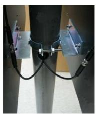
Скрепите два кронштейна на нижней части знака (рядом с отверстием для проводов), затем соедините провода солнечной панели с батарейным блоком со знаком
